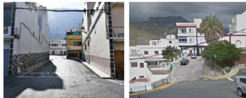
Imagen 28: Infraestructura peatonal de Mogán Casco. Fuente: Ayuntamiento de Mogán y Google Maps.
