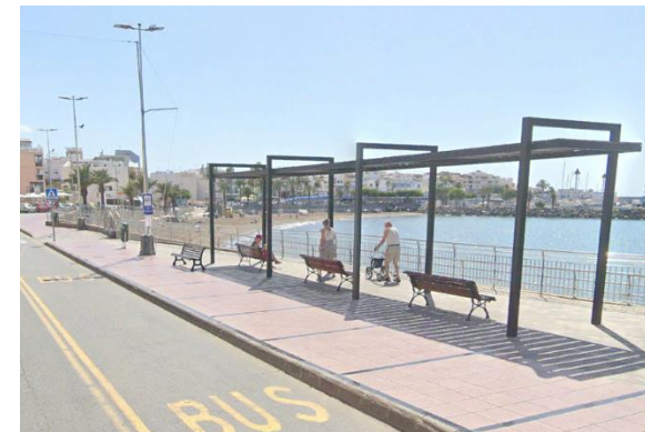
Imagen 31: Paseo marítimo Playa de Marañuelas y Puerto de Arguineguín. Fuente: Google Maps y La Provincia
